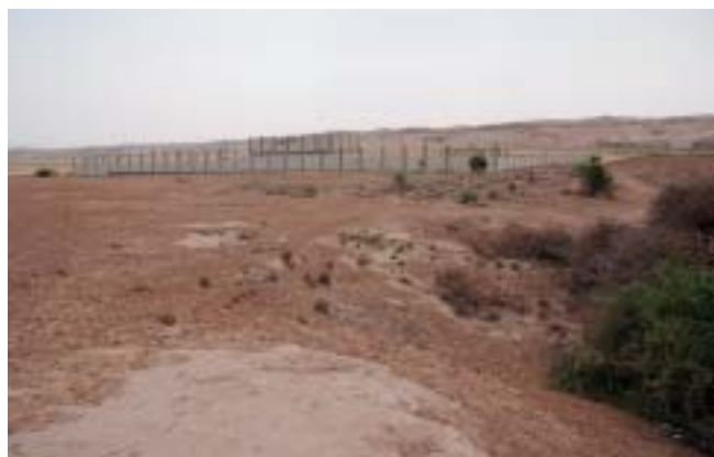
写真2 テル・ガーネム・アル・アリ遺跡の南側、建設現場（北より撮影）
