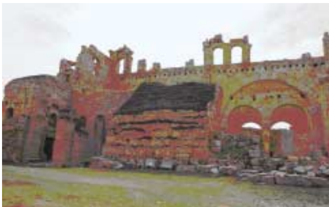
写真10 ルサーファ要塞内部
