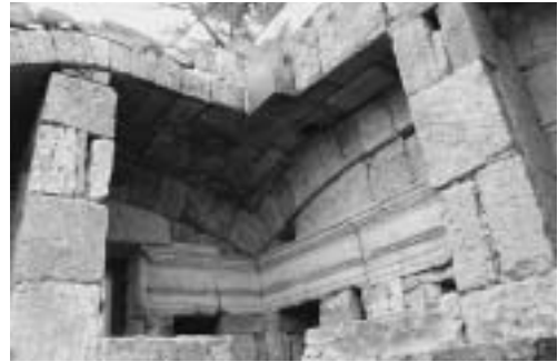
図8 ティール、ゴルフ・マトワニーヤ、切石組による天井架構(2006年)
