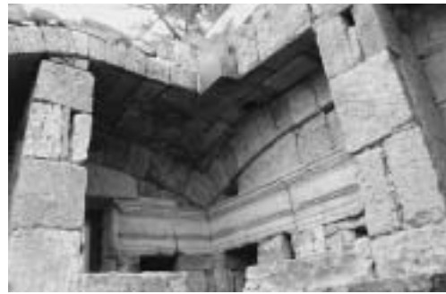
図8 ティール、ゴルフ・マトワニーヤ、切石組による天井架構(2006年)
