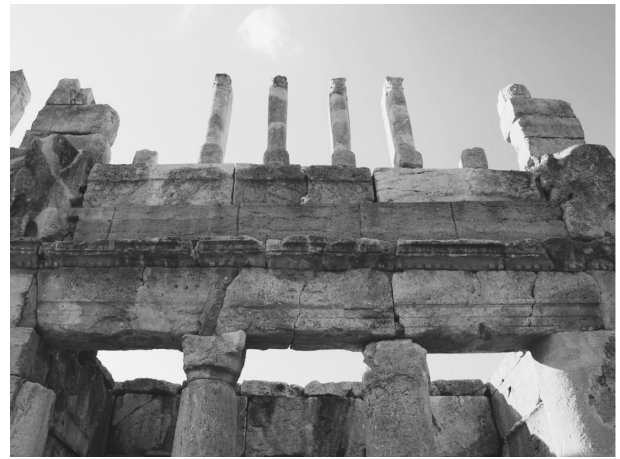
写真5 南ファサード見上げ
