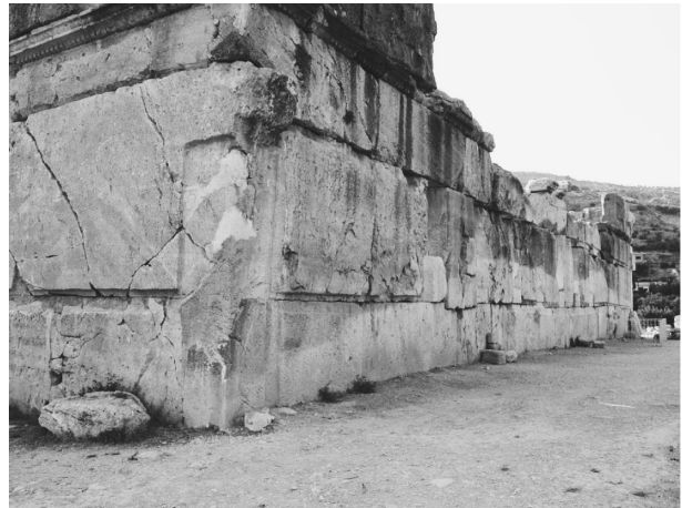
写真7 一階外壁の石積と目地（東側面）
