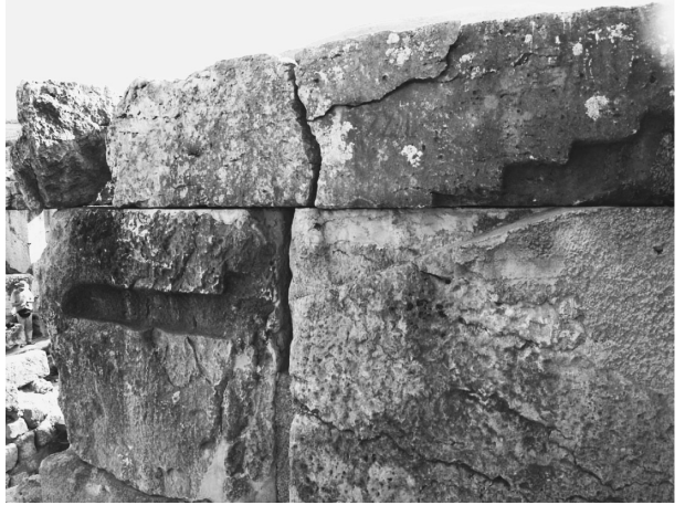
写真11 外壁内部にある階段スラブのソケット
