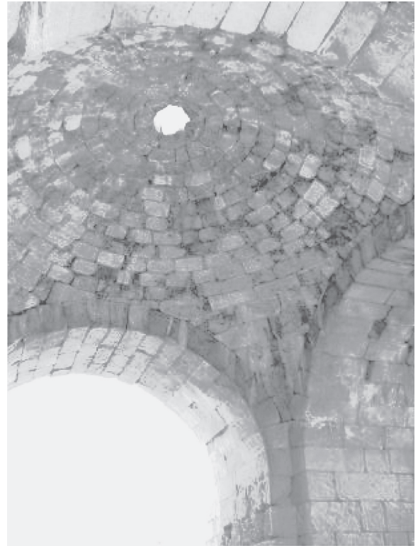
図5 ジェラシュ、ローマ時代西浴場跡の切石積み上部架構 (2005年)
